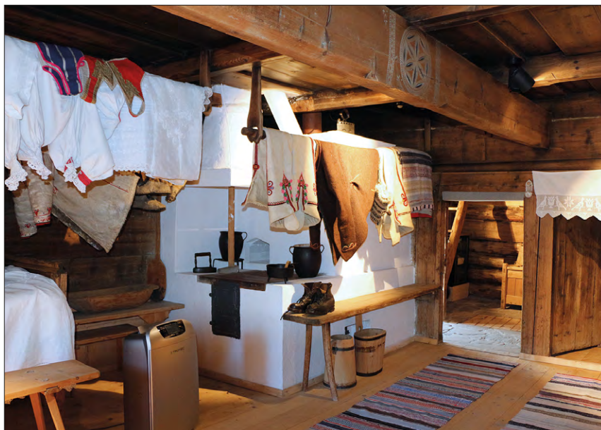
FOT. 11 Izba w Zagrodzie Sołtysów w Jurgowie z powalą deskowaną na zakładkę, tragarzami i sosrębem ozdobionym rozetą – symbolem solarnym. Fot. J. Barański
