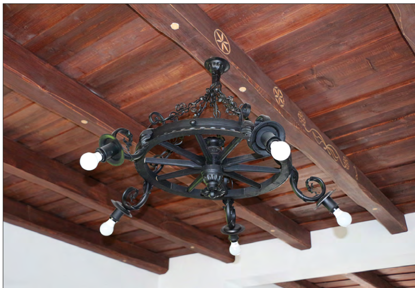
FOT. 12 Powala z desek w Pensjonacie Spiskim z tragarzami zdobionymi rozetami oraz metalowy żyrandol stylizowany na koło. Fot. J. Barański
