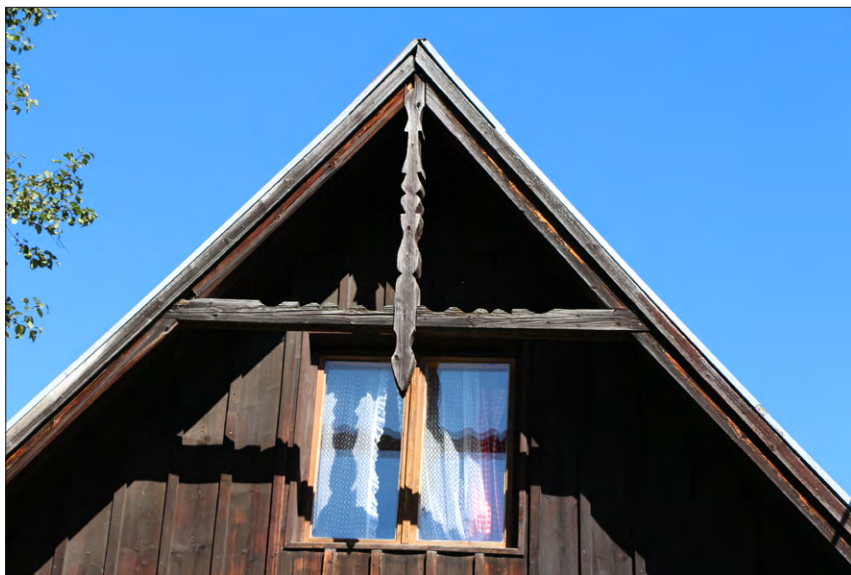
FOT. 5 Szczyt starego domu z jętką zewnętrzną, Osturnia. Fot. J. Barański
