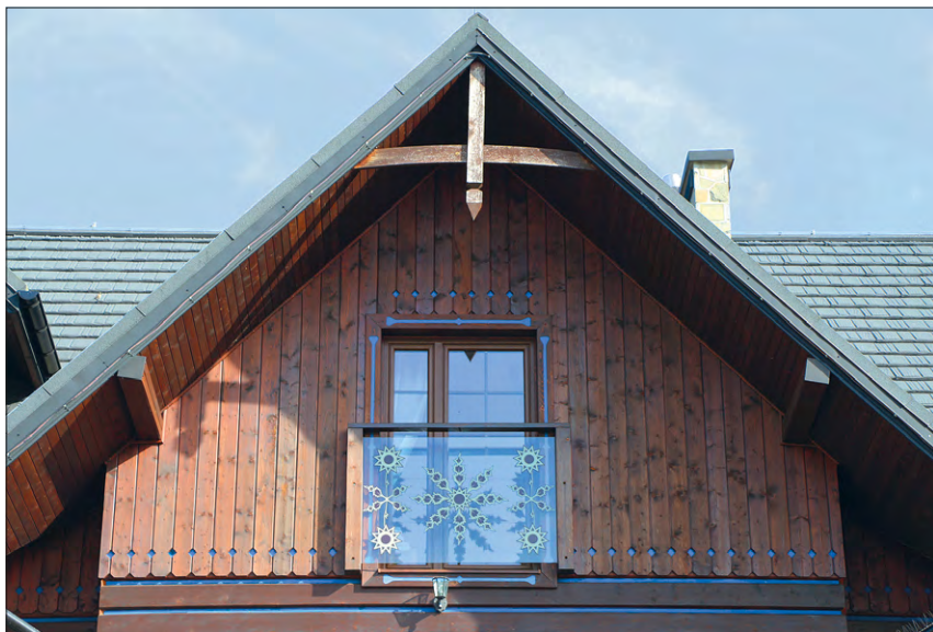
FOT. 6 Rezalit (wystawka) Pensjonatu Spiskiego z okapem, deskowaniem, ornamentem obramienia okiennego w kolorze ultramaryny, stylizowaną jętką zewnętrzną, plus dekoracyjny motyw dziewięciśł beżłodygowego na płycie szklanej portfenetru (balustrady francuskiej). Fot. J. Barański
