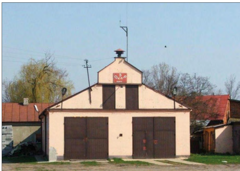
FOT. 3 Synagoga w Gniewoszowie zaadaptowana na Strażnicę Ochotniczej Straży Pożarnej. Fotografia wykonana przed generalnym remontem budynku w 2019 r. Zbiory autorki.
