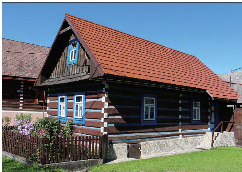
FOT. 2 Stary dom spiski; na uwagę zasługują wypełnienia między płazami i opaski okienne w kolorze ultramaryny oraz dekoracja kostkowa narożników, Osturnia. Fot. J. Barański
