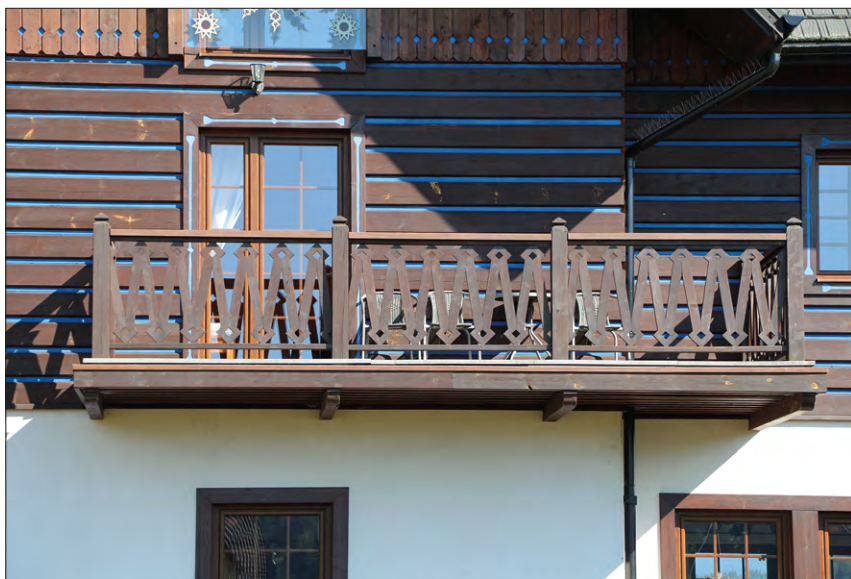
FOT. 9 Pensjonat Spiski, balkon; zastosowany motyw niewielkich ultramarynowych kwadratów u dołu szalunku szczytowego powtarza się w formie otworów w snycerze balustrady. Fot. J. Barański
