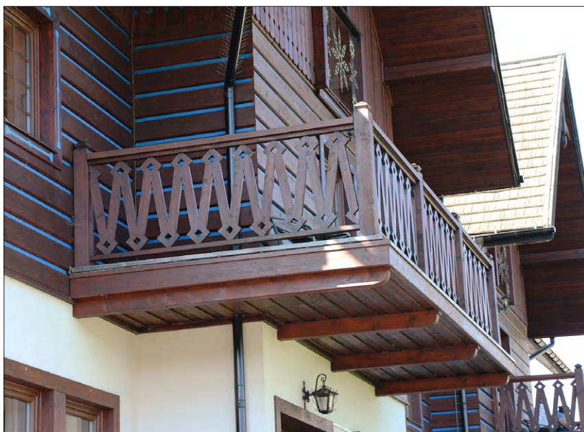
FOT. 13 Rysie „podtrzymujące” balkony Pensjonatu. Fot. J. Barański
