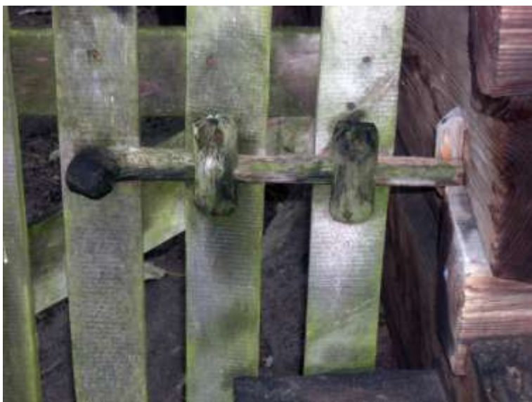
Ryc. 2 – drewniana zasuwka z Muzeum Rolnictwa im. ks. Krzysztofa Kluka w Ciechanowcu. (fot. A. Marciniak-Kajzer)
