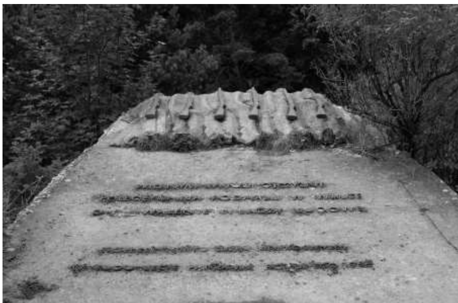
Ryc. 3. Płyta pozioma pomnika w 2007 r. przed renowacją (fot. Szymon Swoboda)
