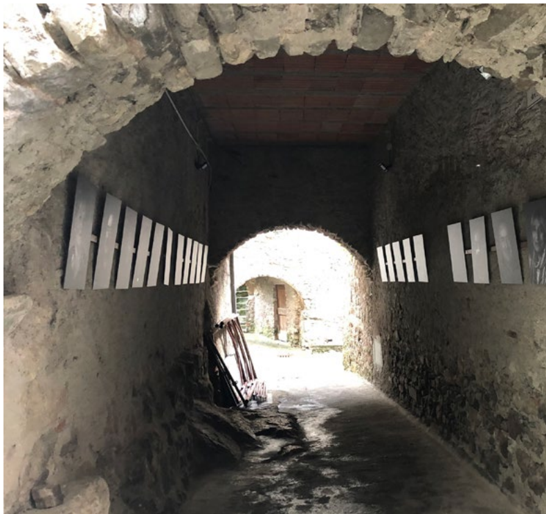
Fot. 7. Tunel w Vallico Sotto z kolekcją fotografii
