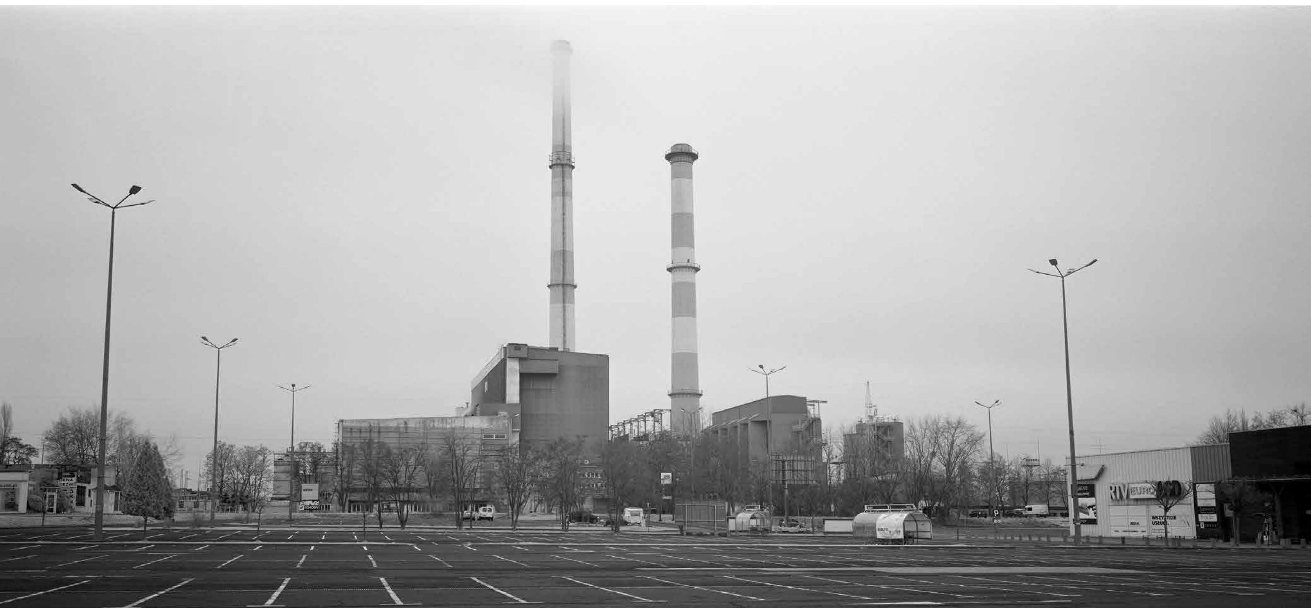
Elektrociepłownia EC3, Łódź
