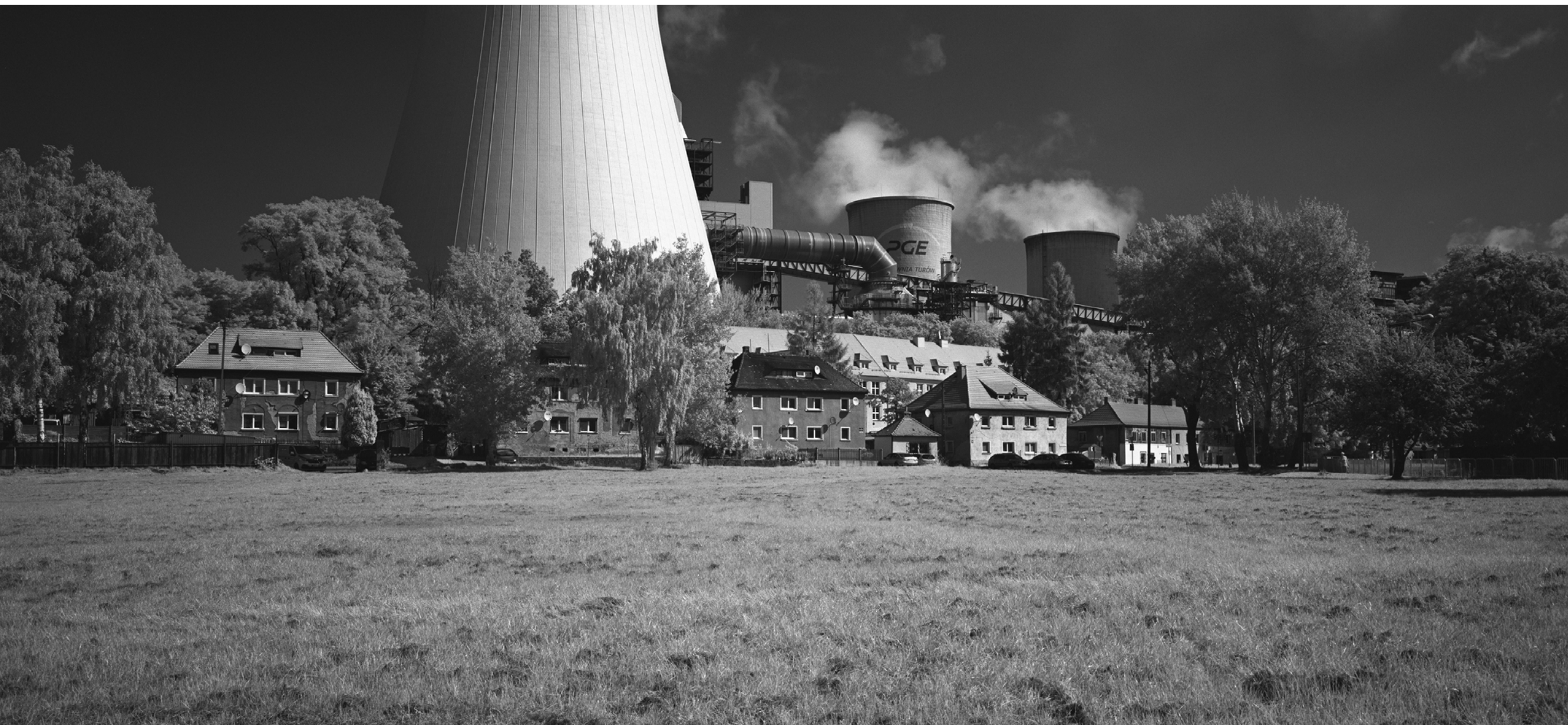
Elektrownia Turów, Trzcinec Dolny
