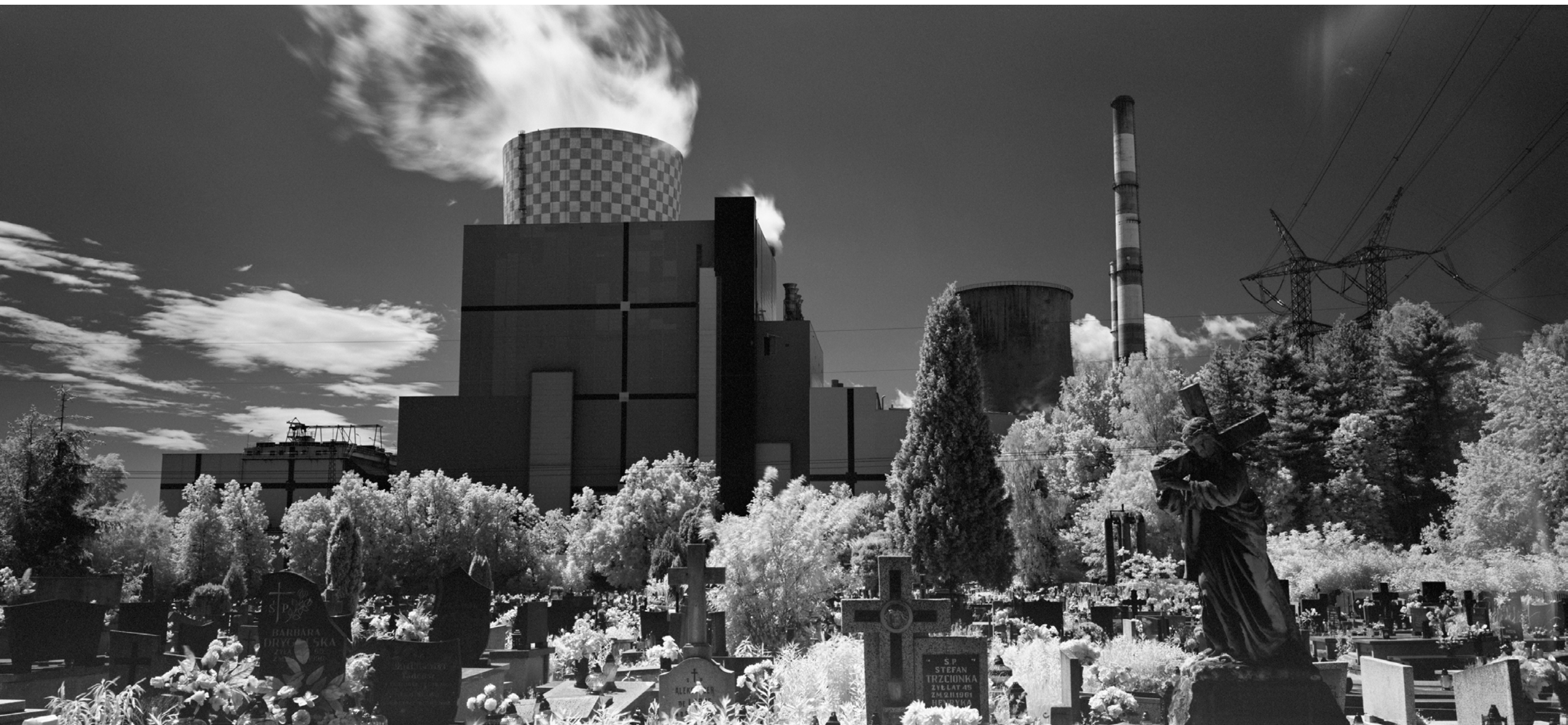
Elektrownia Łagisza, Będzin
