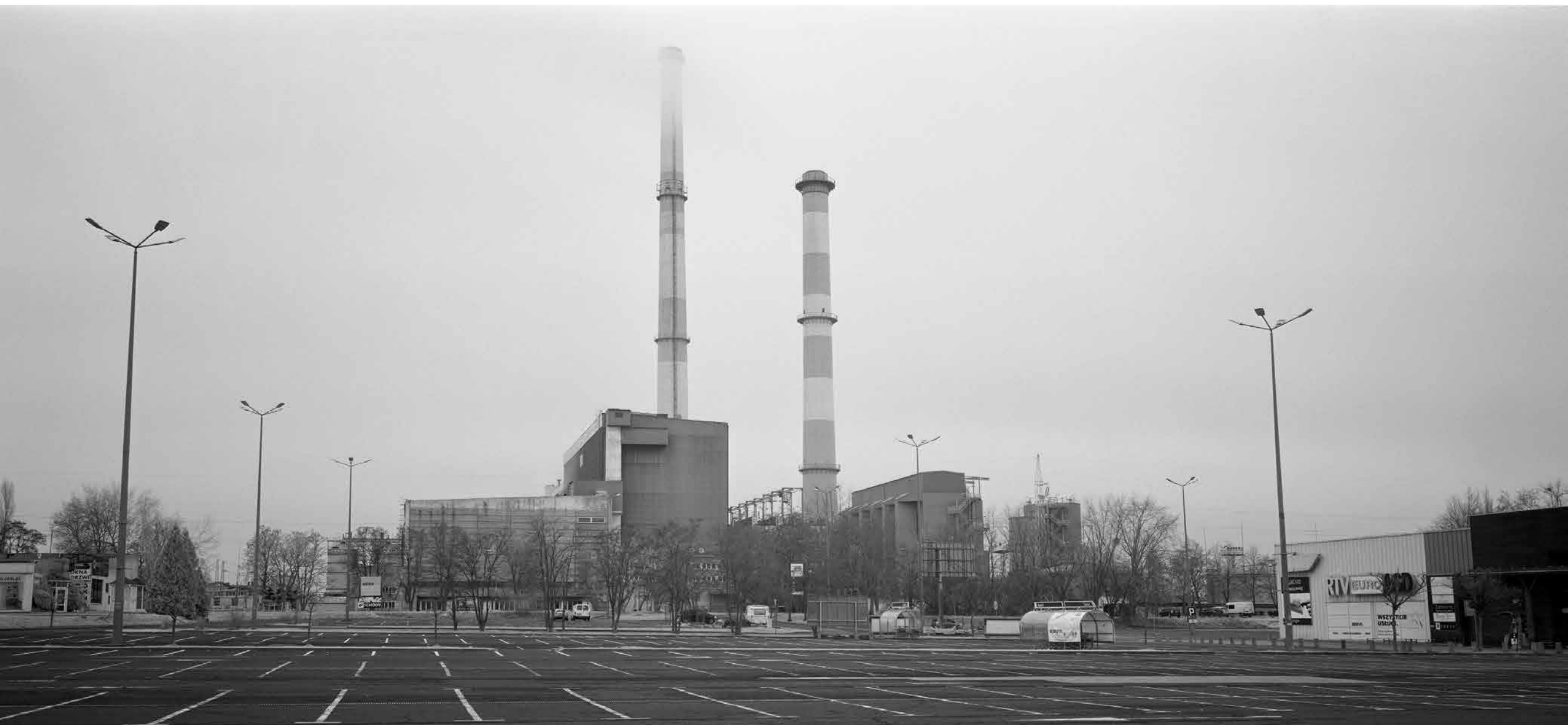
Elektrociepłownia EC3, Łódź
