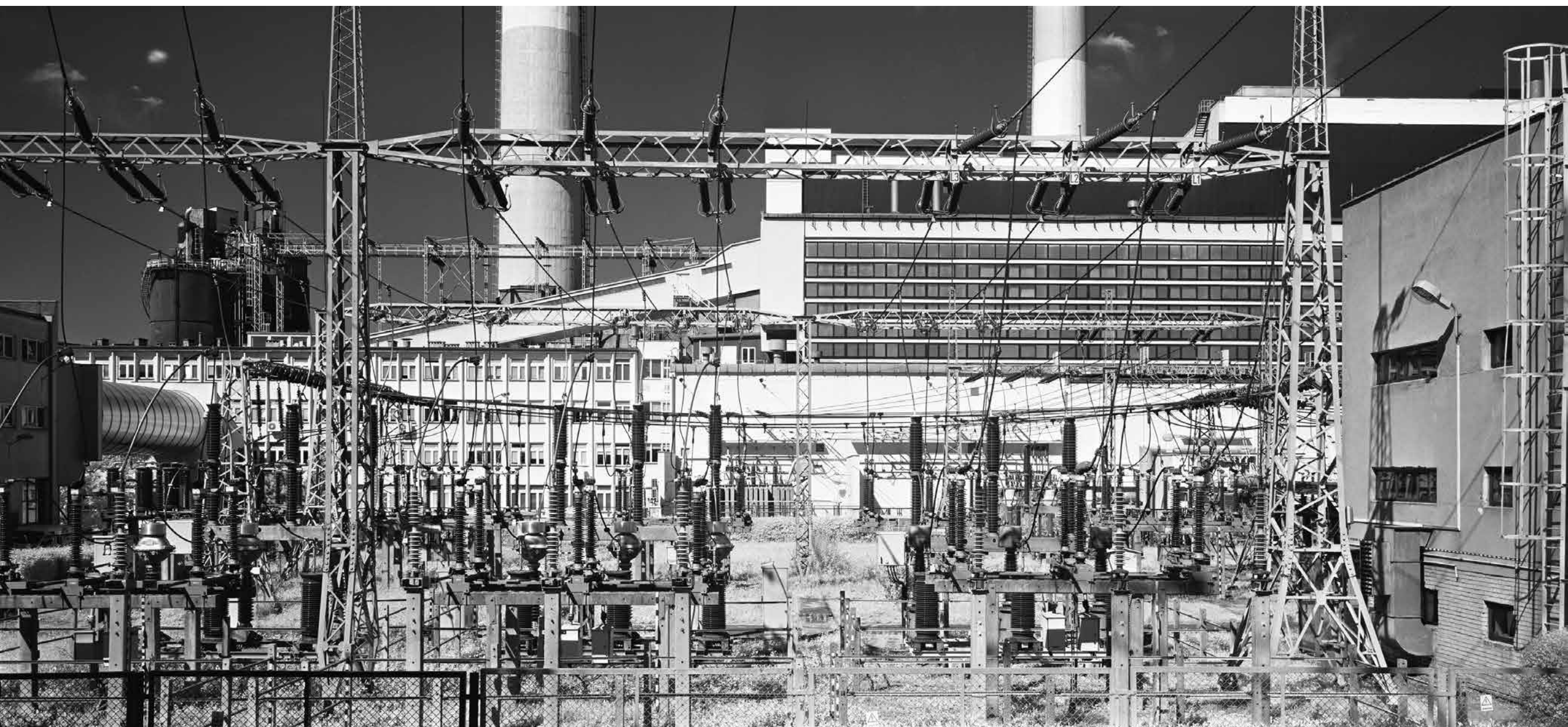
Elektrociepłownia EC3, Łódź
