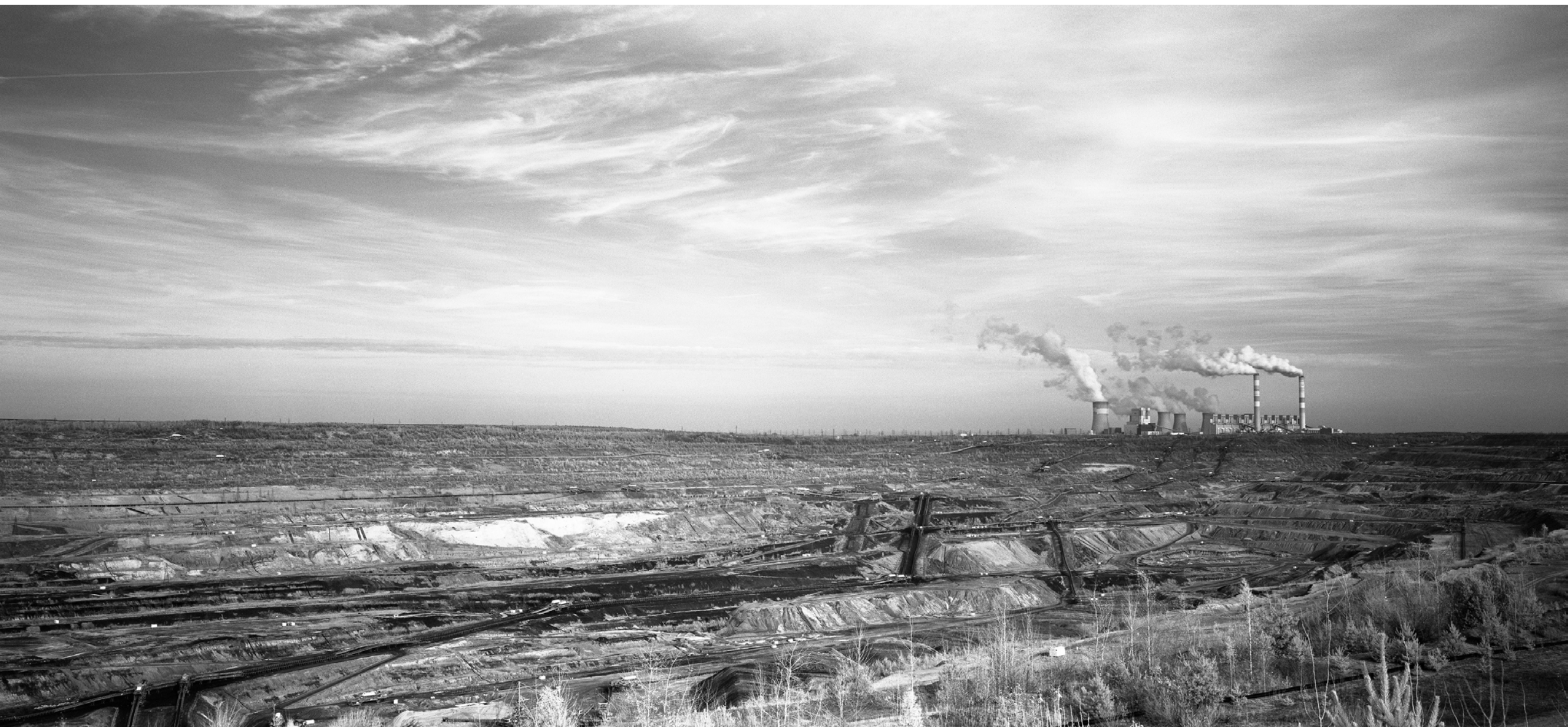
Kopalnia Węgla Brunatnego Bełchatów i Elektrownia Bełchatów
