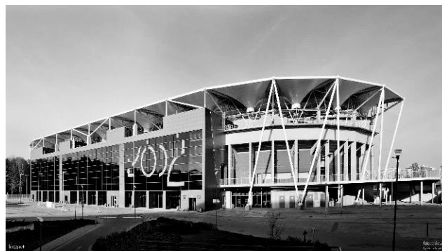
Fot. 3. Stadion miejski (ŁKS - w budowie) Źródło: http://fotopolska.eu/stadiony
