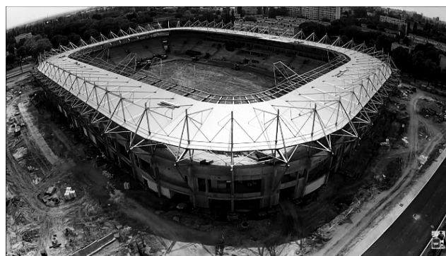
Fot. 4. Stadion miejski (RTS Widzew - w budowie) Źródło: https://www.youtube.com
