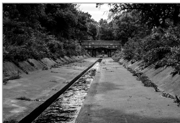
Fot. 6. Betonowy żłób Jasienia. W oddali ceglany most przy ul. Cieszkowskiego. Fot. J. Jędruszkiewicz
