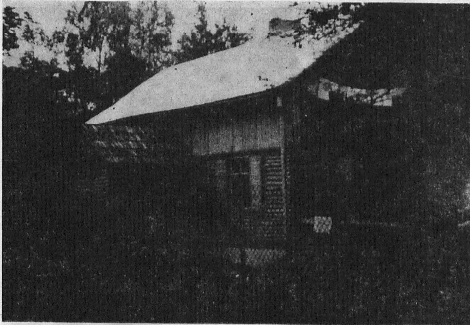
Fot. 2. Dom letniskowy (Rydzyński). Dom zbudowany wg projektu indywidualnego na podmurówce. Działka usytuowana na skraju lasu
