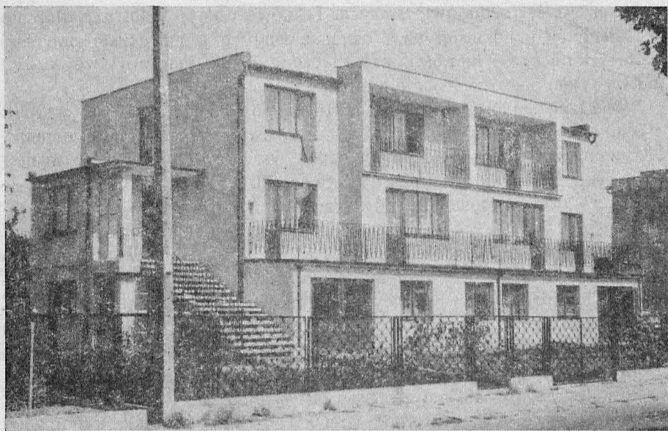
Fot. 5. Chałupy, budynek mieszkalny z lat 1970/1980
