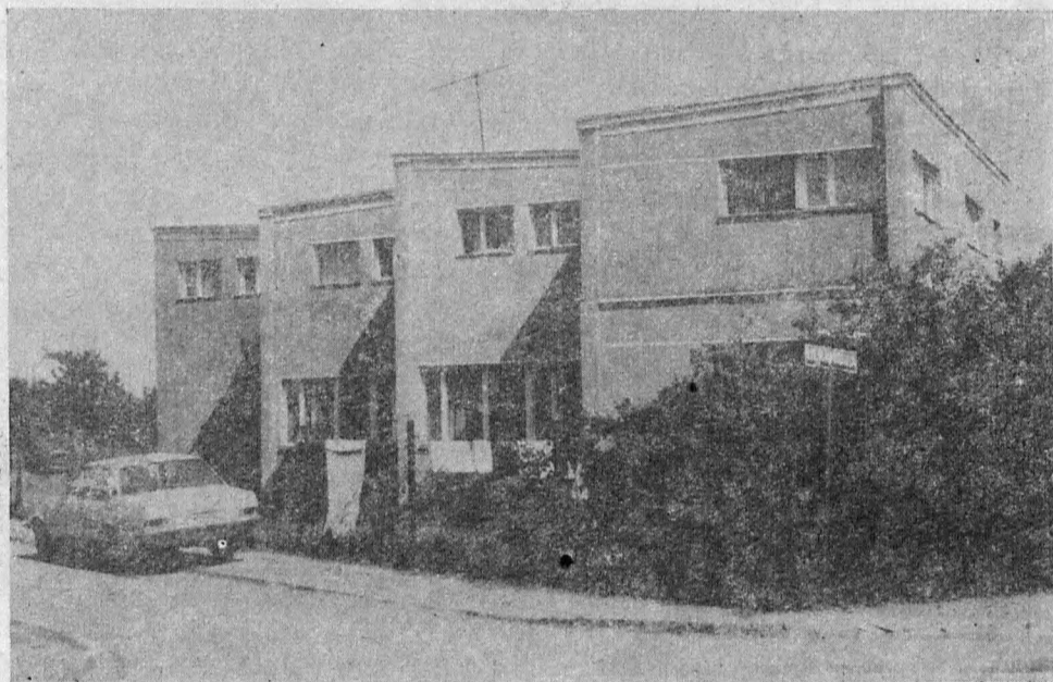
Fot. 4. Chałupy, budynek mieszkalny z lat siedemdziesiątych Chałupy, maison d'habitation des années soixante-dix
