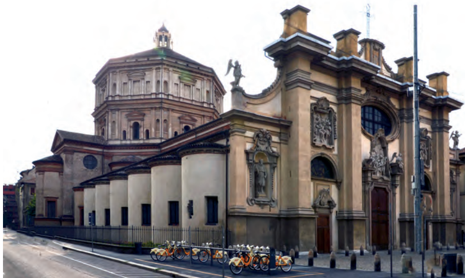
4. Kościół Santa Maria della Passione w Mediolanie, kaplice przy korpusie, arch. Martino Bassi, rozpocz. 1573, fot. Michał Kurzej
