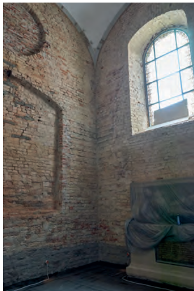
4. Wnętrze kaplicy podczas remontu w 2018 roku – widok ku południowemu zachodowi, fot. Mikołaj Potocki
