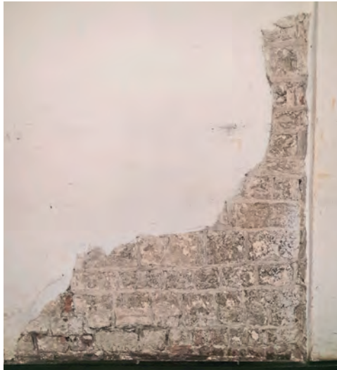
6. Kraków, katedra, relikw kamiennej przypory we wschodniej ścianie dawnej kaplicy św. Mikołaja, fot. Jakub Adamski
