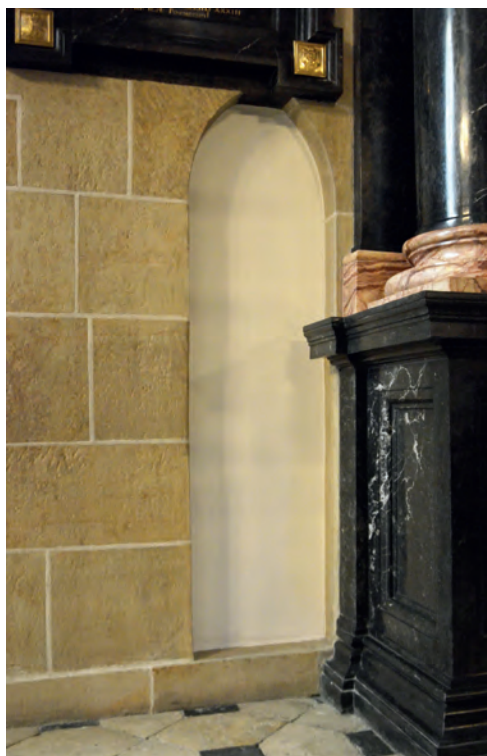
10. Kraków, katedra, otwór w ścianie nawy południowej pierwotnie prowadzący do kaplicy św. św. Piotra i Pawła, fot. autor
