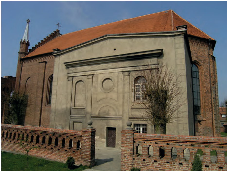
3. Elewacja południowa kaplicy, zakrystii i łoży kolatorskiej, fot. Paweł Grabowski, 2005
