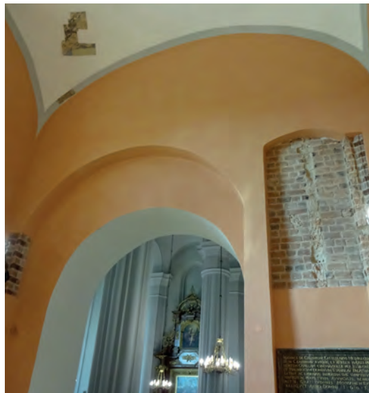
5. Północna, wewnętrzna elewacja kaplicy i fragment czaszy sklepiennej – stan po ostatniej renowacji z 2018 roku. Widoczne „świadki” – fragmenty polichromii na sklepieniu i odsłonięte częściowo gotyckie lizeny z XV wieku, fot. autor, 2019
