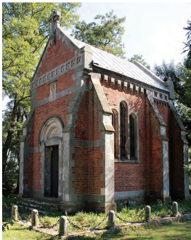
1. Kaplica grobowa Trębickich w Zembrowie – elewacje frontowa i boczna Fot. M. Wiraszka, 2011
