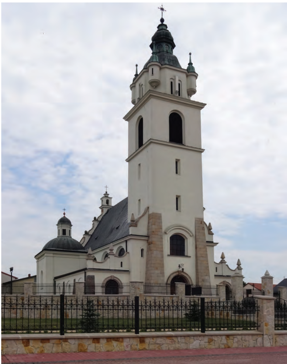
5. Kościół w Klwowie, 1924–1931, arch. Kazimierz Prokulski. Fot. A. Tejszerska
