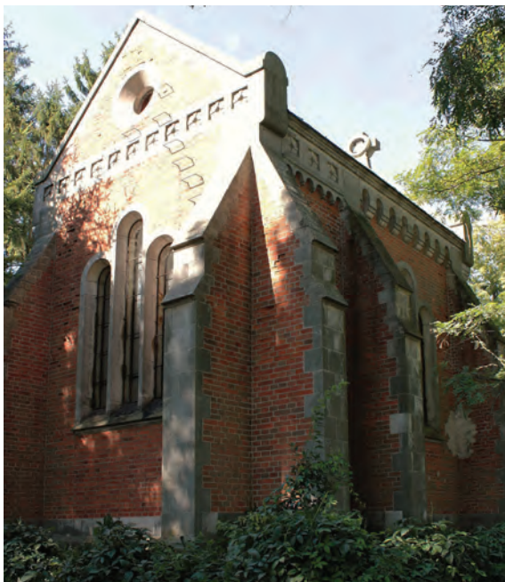
2. Kaplica grobowa Trębickich w Zembrowie – elewacje tylna i boczna. Fot. M. Wiraszka, 2011
