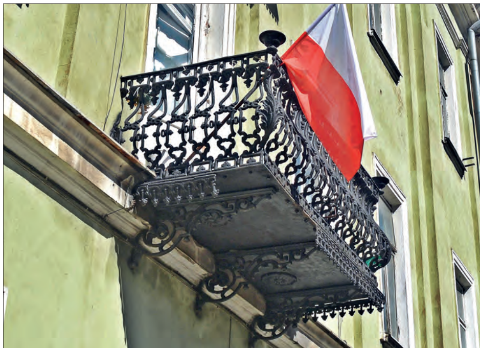
4. Balkon żeliwny na elewacji frontowej przy ul. Piłsudskiego 19 na wspornikach z motywem putta (rys. 2.2), z rozetami na płycie (rys. 3.1) i z „wybrzuszoną” balustradą (rys. 1C). W tej konstrukcji zachowały się często wybrakowane lambrekiny (rys. 4.2) i talerzyki w narożach balustrady; fot. autorka, 2024
