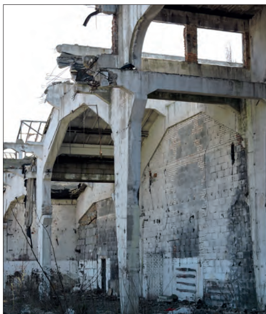
12. Dawne zakłady Towarzystwa John, Krebs i S-ka, później Fakora, w trakcie rozbiórki. Fot. K. Stefański, 2015
