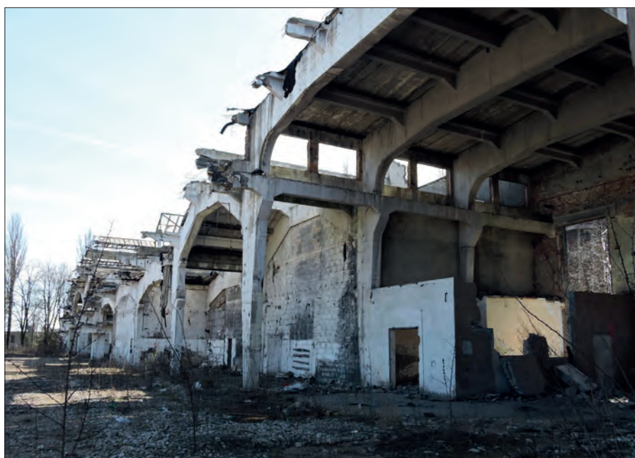
10. Dawne zakłady Towarzystwa John, Krebs i S-ka, później Fakora, hala odlewni w trakcie rozbiórki. Fot. K. Stefański, 2015
