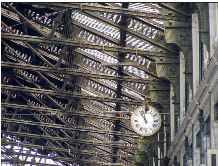
21. Dekoracje dźwigarów Polonceau: konsole w hali dworca Paris-Orléans (1868 – góra), konsole i słupki w hali dworca Paris-Lyon (1900 – dół); fot. autor, 2002, 2011
