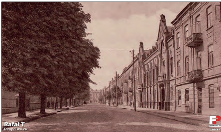
5. Radom, ul. Piłsudskiego, 1930–1939, pocztówka, widoczny budynek nr 17 przed demon- tażem balkonów (od prawej); https://fotopolska.eu/Radom/u159289,ul_Pilsudskiego_Jozefa_marsz.html?f=270435-foto [dostęp: 30.04.2024]
