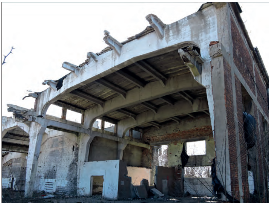
11. Dawne zakłady Towarzystwa John, Krebs i S-ka, później Fakora, hala odlewni w trakcie rozbiórki. Fot. K. Stefański, 2015
