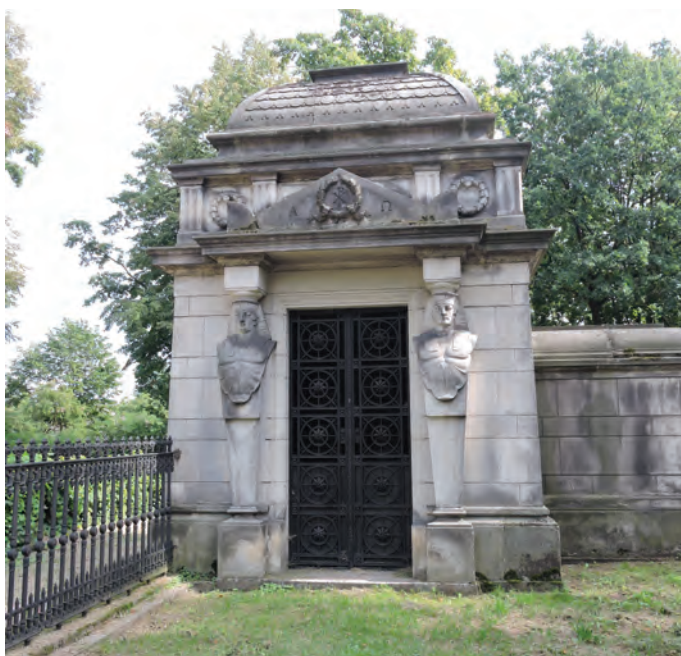
12. Pole grobowe rodzin Schloesserów i Wernerów na cmentarzu ewangelicko-augsburskim w Ozorkowie – kaplica grobowa Henryka (Heinricha) i Karola (Carla) Schloesserów, fasada. Fot. K. Stefański
