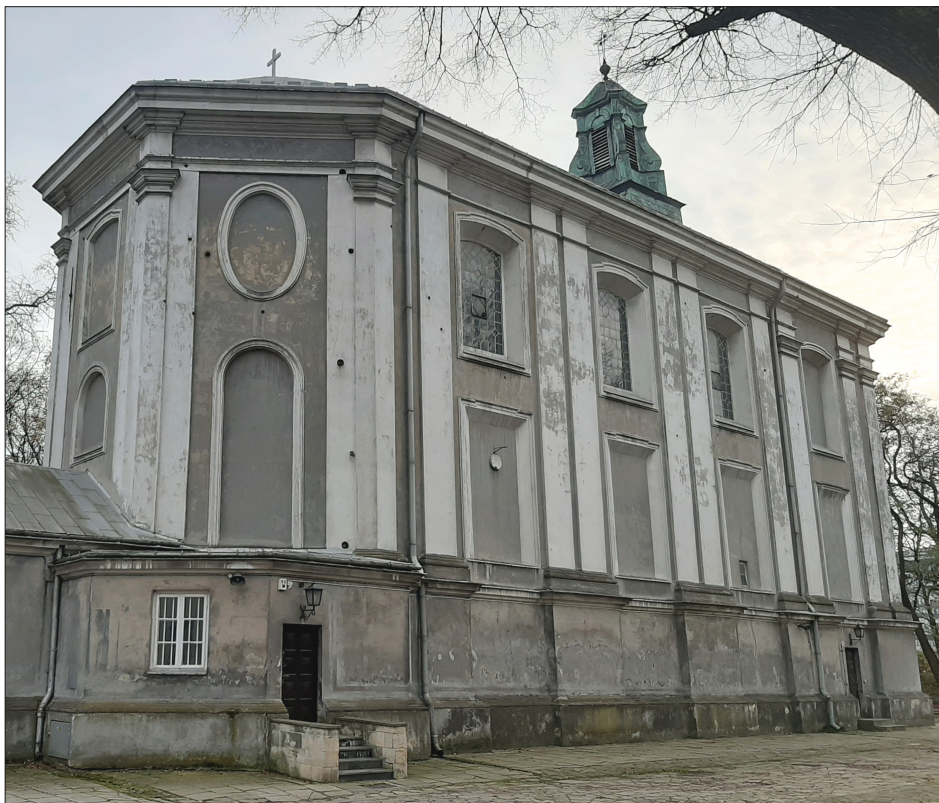
9. Kościół św. Wawrzyńca na Woli, elewacja północna i wschodnia (prezbiterium), fot. autor, 2022
