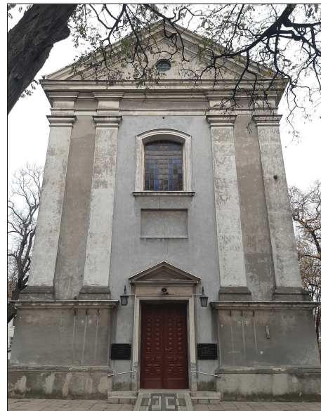
3. Fasada kościoła na Woli , fot. autor, 2024
