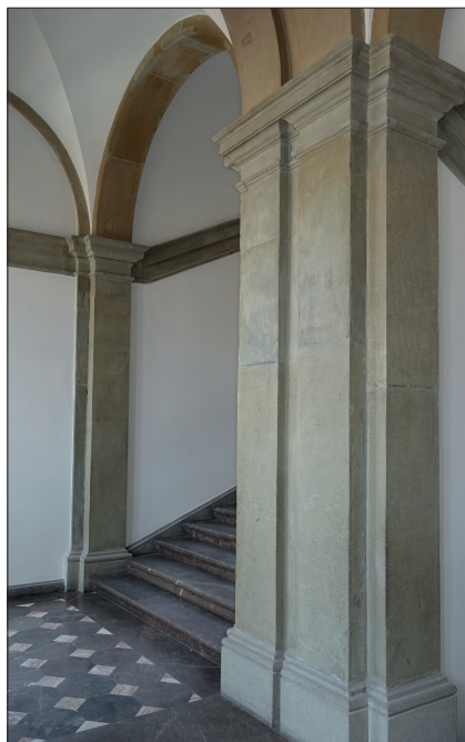
9. Zamek Królewski na Wawelu, artykulacja pilastrowa, podest między parterem a I piętrem; fot. autor, 2022
