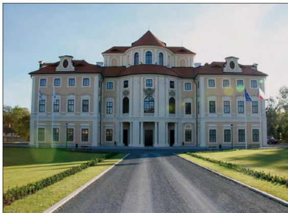
4. | G. B. Alliprandi, pałac w Liblicach (Czechy) – elewacja frontowa, fot. autor
