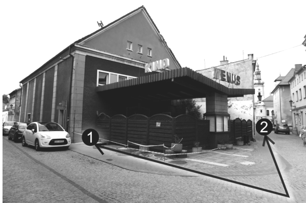
Ryc. 7. Zależność przestrzenna a oś widokowa – synagoga i kościół ewangelicko-augsburski w Pszczynie (1 – obiekt posynagogałny, 2 – kościół) Źródło: fot. i opracowanie A. Majewska
