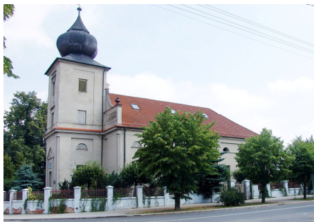
Ryc. 2. Kościół ewangelicko-reformowany w Żelowie Źródło: fot. M.J. Battek
