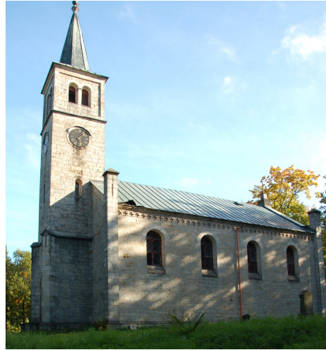
Ryc. 3. Kościół ewangelicko- reformowany w Pstrążnej koło Kudowy Zdroju
