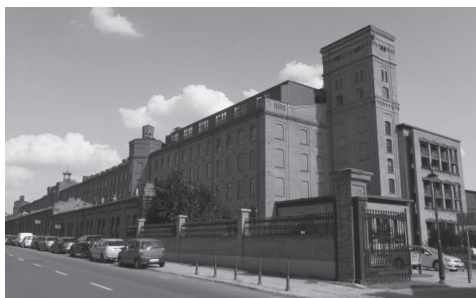
Fot. 3. Budynek przędzalni po przeprowadzonej adaptacji na lofty (widok z ul. Tymienieckiego)
