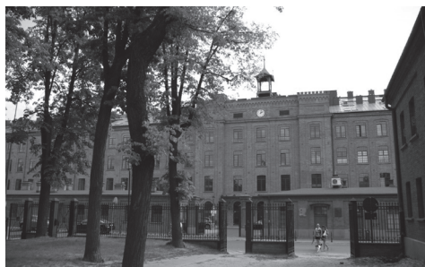
Fot. 4. Budynek przędzalni po przeprowadzonej adaptacji na lofty (widok z osiedla robotniczego Księży Młyn)
