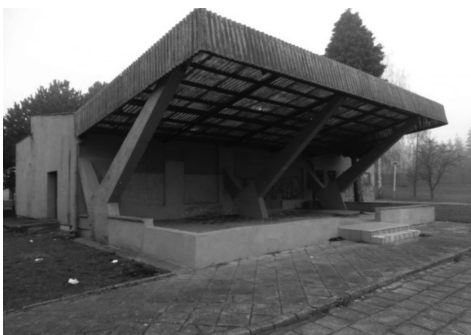
Fot. 2. Budynek restauracji z tarasem fot. R. Torzewski (2016)
