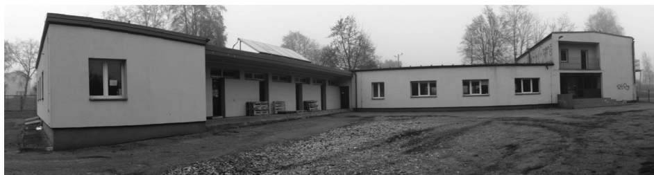
Fot. 3. Pawilon sportowy, sala gimnastyczna oraz hotel – widok od strony frontu fol. R. Torzewski (2016)
