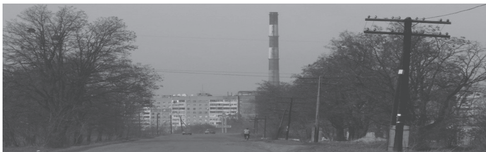
Fot. 3. Kominy elektrowni jako główna dominanta miasteczka Dobrotwór, Ukraina fot. O. Dyda (2017)
