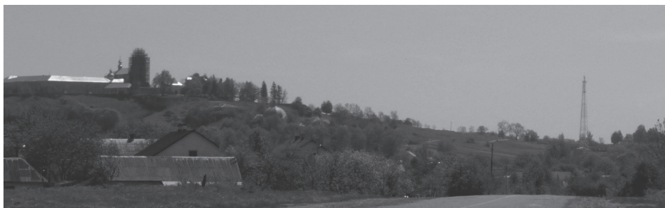
Fot. 5. Połączenie dominant zabytkowych i technicznych w krajobrazie miejskim. Miasteczko Podkamień, Ukraina fot. O. Dyda (2017)
