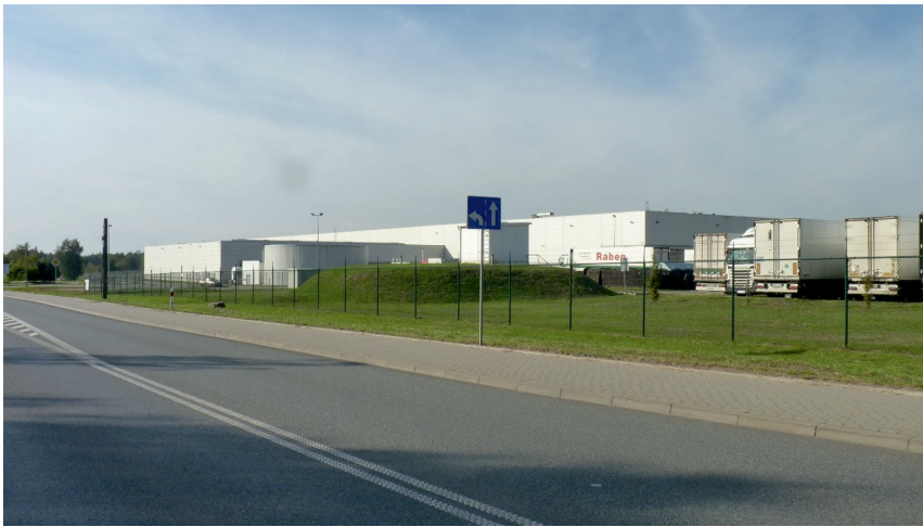
Fot. 1. Zabudowania Raben Logistics Polska we wsi Smolice
