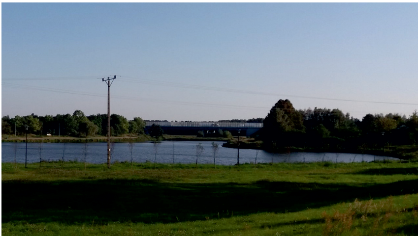
Fot. 3. Zalew na Moszczenicy w Strykowie – widok na wiadukt autostrady A2 fot. I. Pielesiak (2017)
