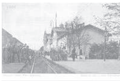
Fot. 3. Dworzec kolei fabrycznej – łódzkiej
