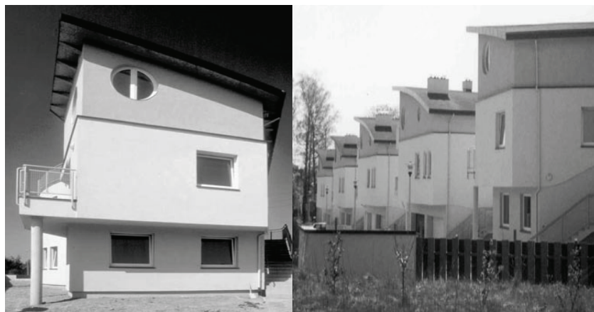
Fot. 15. Budynki szeregowe zbudowane przez Exbud – ul. Świtezianki, Łódź
