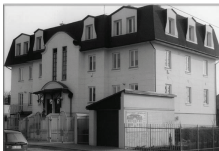
Fot. 10. Budynek zbudowany przez firmę Abart w technologii tradycyjnej – ul. Kogucia, Łódź
