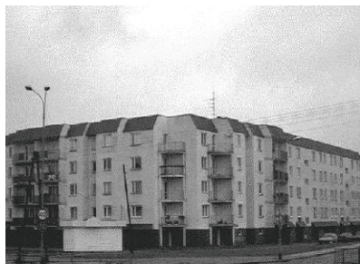
Fot. 3. Blok RSM „Bawełna” wzniesiony w technologii wielkopłytywowej – ul. Kmicica w Łodzi Źródło: zdjęcie wykonane przez autora
