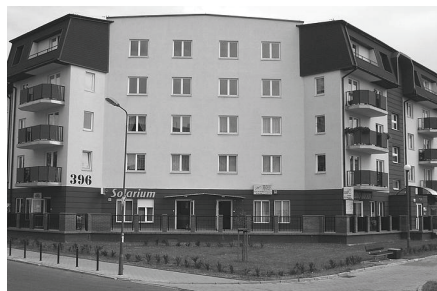
Fot. 4. Blok wzniesiony w technologii wielkopłytywowej – ul. Armii Krajowej w Łodzi Źródło: zdjęcie wykonane przez autora
