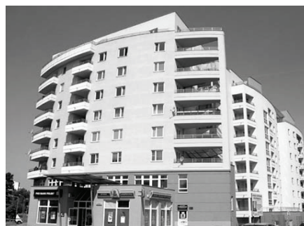
Fot. 6. Blok wzniesiony w technologii monolitycznej – ul. Królewska, Łódź Źródło: zdjęcie wykonane przez autora
