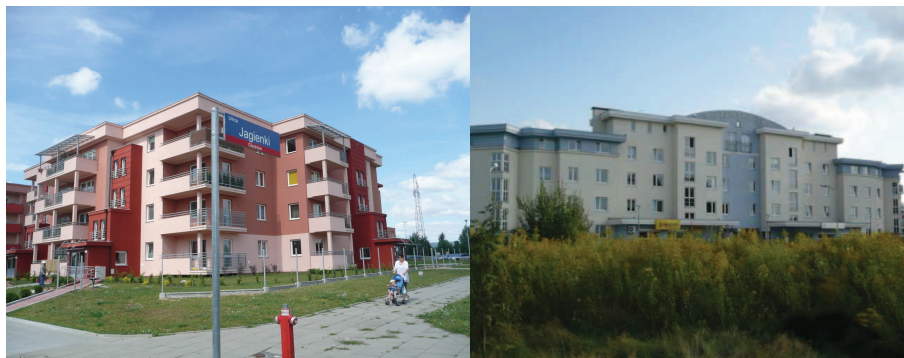
Fot. 1. Budynek przy ul. Jagienki 31
