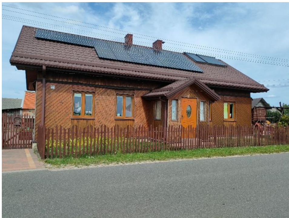
Fot. 3. Dom drewniany w Trzciance (gm. Łyszkowice)
