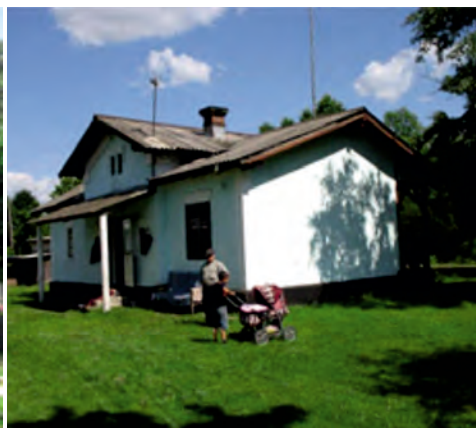
Fot. 6. Dworzec Kupka Bukowina Północna
