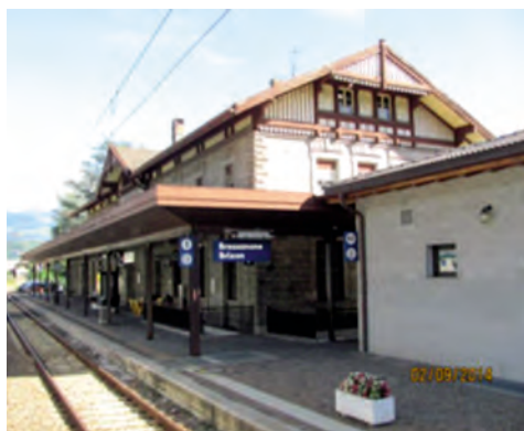
Fot. 21. Dworzec Bressanone/Brixen Tyrol Południowy
