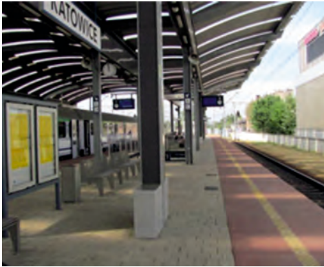
Fot. 25. Peron dworca w Katowicach
