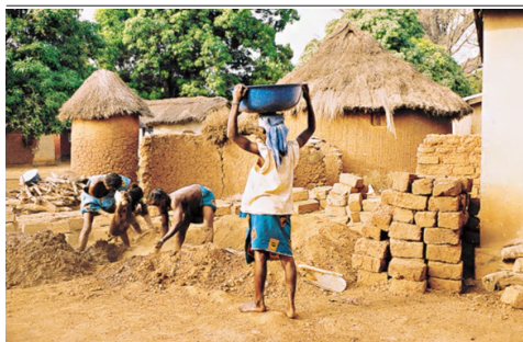
Budowa domu, Wybrzeże Kości Słoniowej Źródło: EM PWN (2000).
