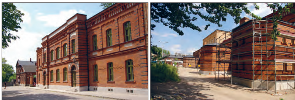
Fot. 14, 15. Budynek dawnej szkoły, w której powstaje Akademickie Centrum Designu ASP Źródło: E. Masierek, 2016
