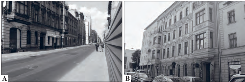
Ryc. 7. Odnowiona i adaptowana na nowe funkcje historyczna kamienica przy ul. Sienkiewicza 65: a) Stan przed rewitalizacją; b) Stan po rewitalizacji w roku 2014
