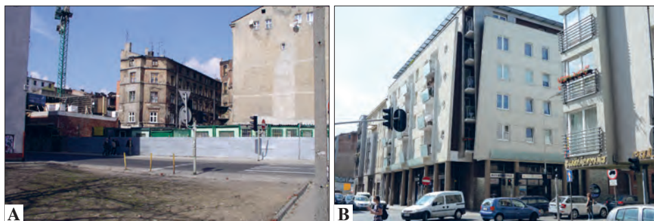
Ryc. 5. Nowy budynek mieszkalno-usługowy przy ul. Sienkiewicza 67:
