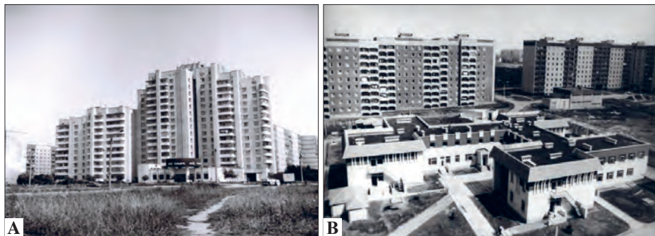
Ryc. 19. Dzielnica mieszkaniowa Sychiw: a) Przedszkole w wewnętrznym dziedzińcu grupy mieszkaniowej; b) Wysokie budynki mieszkalne
