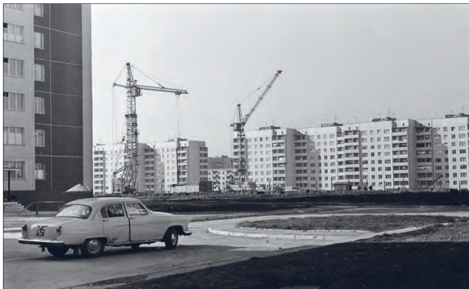
Ryc. 13. Budownictwo osiedla przy ul. Naukowej
