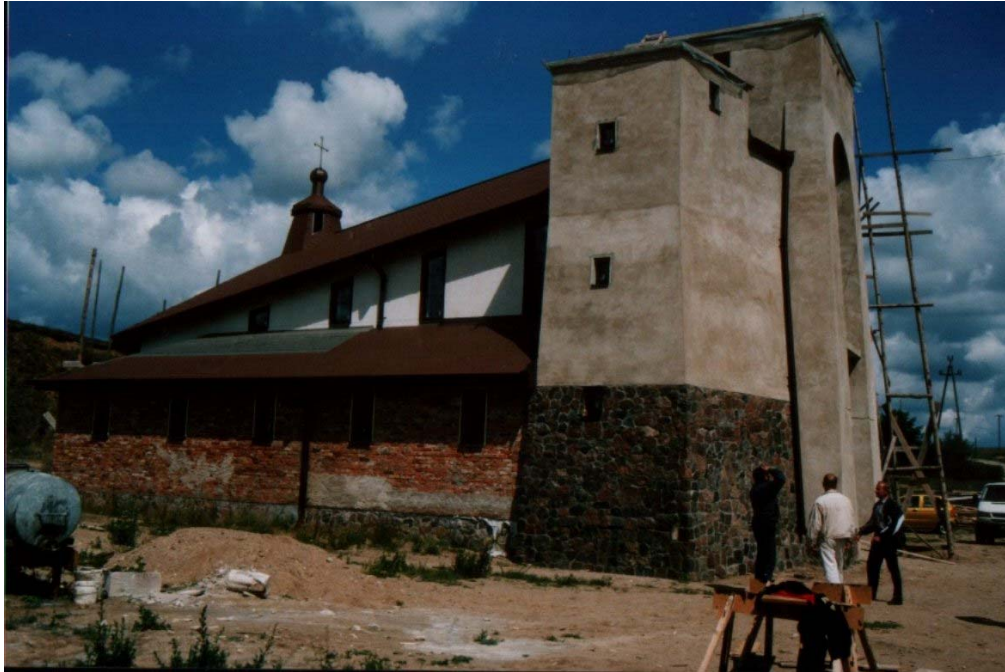
Foto. 2. Kruklanki. Cerkiew grekokatolicka w budowie (zdjęcie pochodzące z badań własnych).
