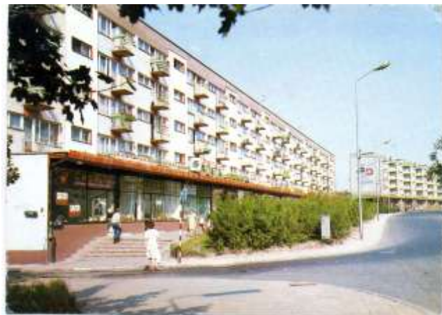
Fot. 14 Ulica Asnyka Źródło: zbiory własne
