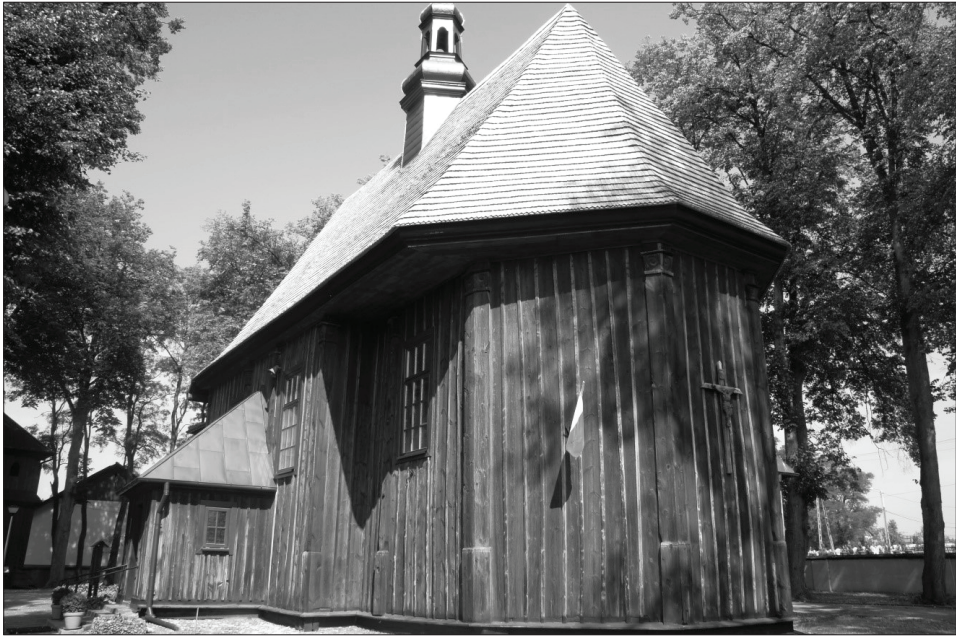
1. Kościół parafialny w Rembieszycach, widok od strony południowo-wschodniej, 2012 r. Fot. M. Karkocha
