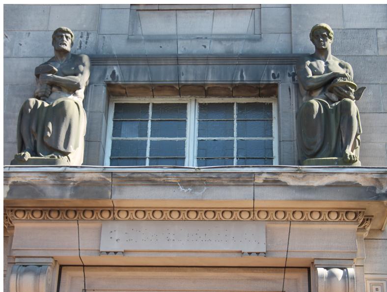
Il. 6. Dekoracja rzeźbiarska fasady: alegorie Przemysłu i Handlu, dawne Towarzystwo Wzajemnego Kredytu Przemysłowców Łódzkich, architekt Wilhelm Martens, 1910–1911, Łódź, ul. Roosevelta 15. Fot. Przemysław Owczarek
