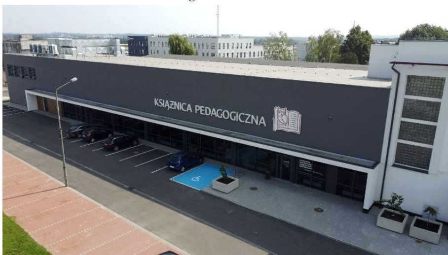
Ryc. 3. Siedziba PBP Książnicy Pedagogicznej im. A. Parczewskiego w Kaliszu, ul. Południowa 62
