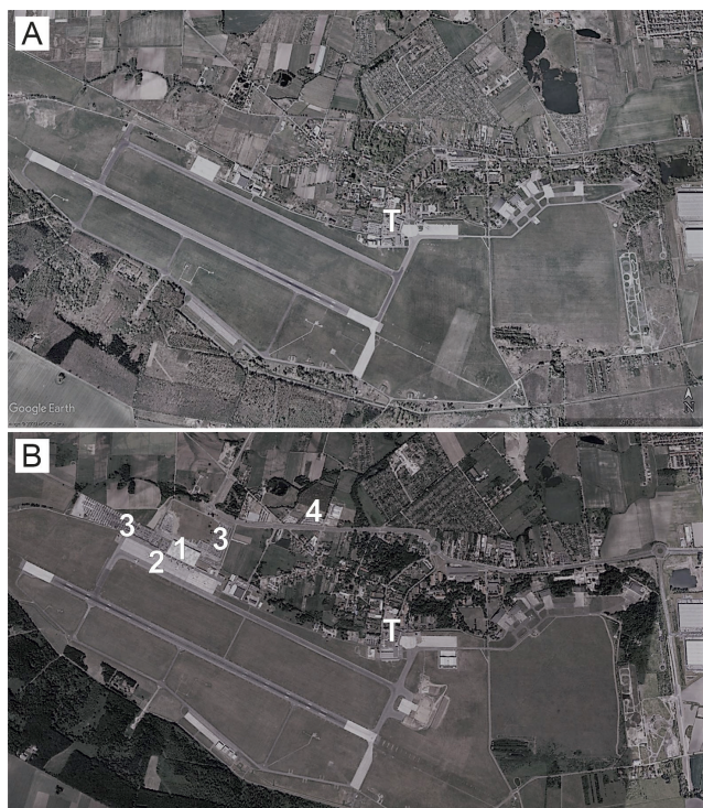
Fotografia 5. Widok na infrastrukturę lotniskową i okołolotniskową oraz układ dróg dojazdowych we Wrocławiu w 2006 r. (A) i w 2018 r. (B)
