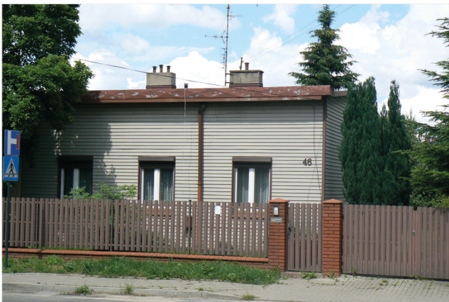
Fotografia 14. Ulica Czechosłowacka 46 Źródło: M. Rejter (2020)
