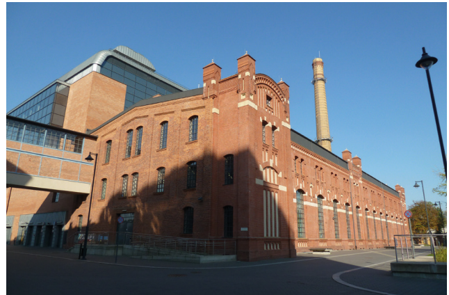
Fotografia 10. Hala maszyn dawnej Elektrociepłowni EC1, aktualnie centrum kulturalne Źródło: Respondent nr 11
