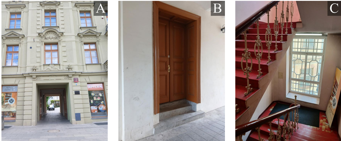
Rysunek 7. Budynek, w którym mieści się Muzeum Farmacji w Łodzi: A – brama wjazdowa, w której znajduje się wejście, B – drzwi wejściowe, C – klatka schodowa Źródło: M. Pośpieszyński, 2025
