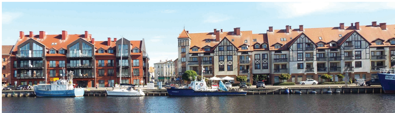
Rysunek 2. Fragment waterfrontu w usteckim porcie z zabudową mieszkaniową i usługową Źródło: T. Michalski
