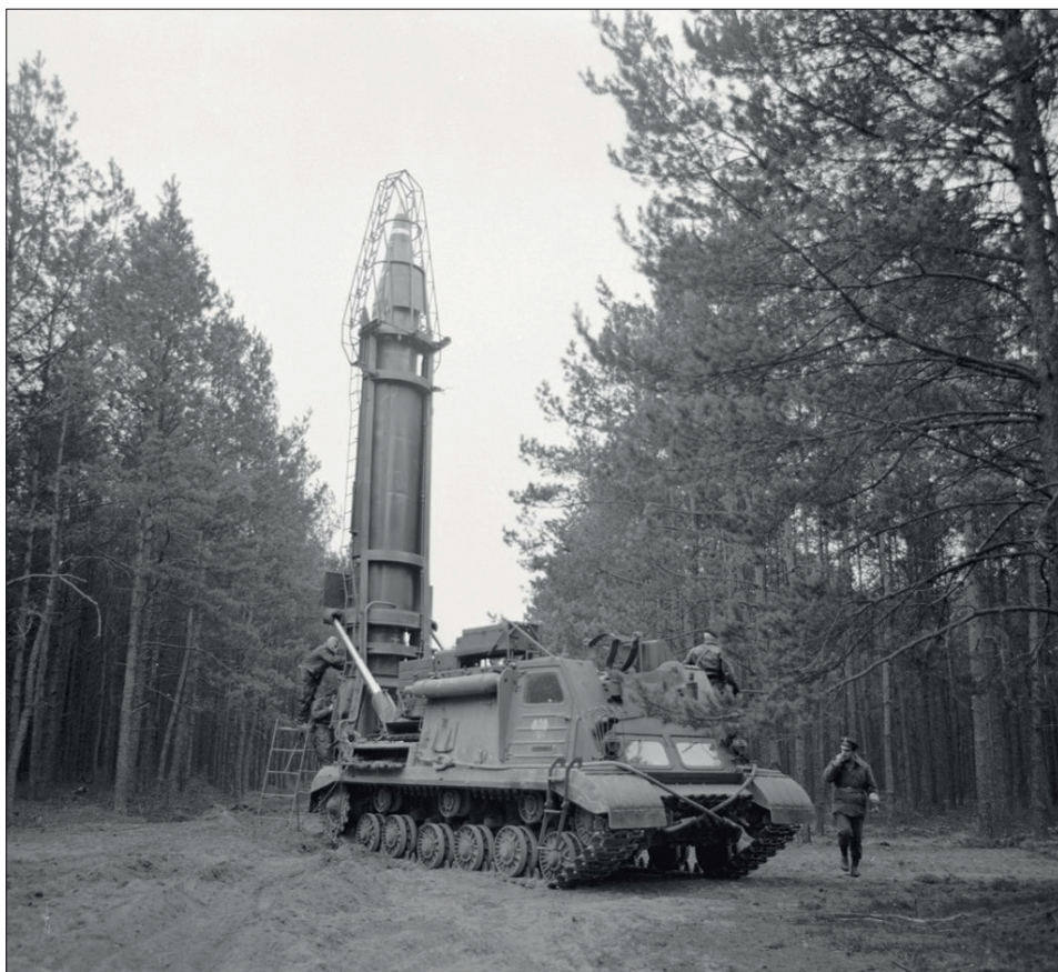
2. Zestaw raketowy 9K51 w położeniu startowym na poligonie w Orzyszu (Źródło: Muzeum Artylerii w Toruniu. Oddział Muzeum Wojsk Lądowych w Bydgoszczy)
