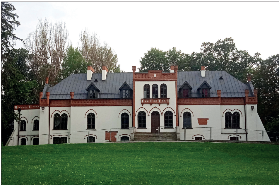
7. Pałac w Ujeździe, elewacja frontowa – stan współczesny. Fot. Ł. Ćwikła
