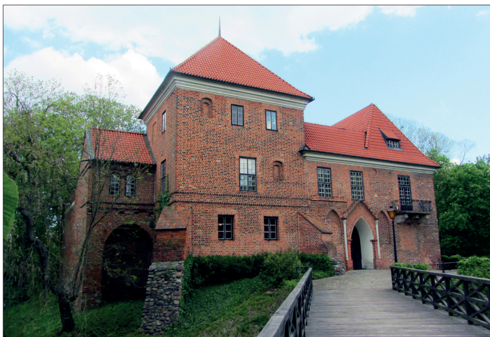
5 a–b. Zamek w Oporowie. Widoki od strony zachodniej i północno-zachodniej Fot. T. Pietras
