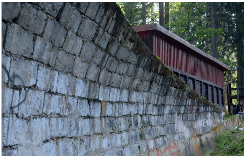
8. Boczne zabezpieczenia toru bobslejowego Fot. J. Panicz, wrzesień 2020 r.
