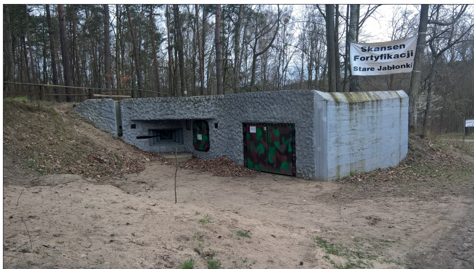
Stare Jabłonki, Pozycja Olsztyńska – schron bojowy dla dwóch karabinów maszynowych i działka przeciwpancernego 37 mm, rok budowy: 1938, stan obecny. Fot. W.B. Łach
