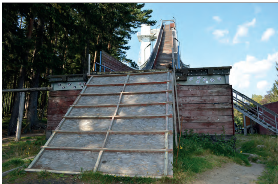
2. Dolna część drewnianego rozbiegu. Fot. J. Panicz, wrzesień 2020 r.
