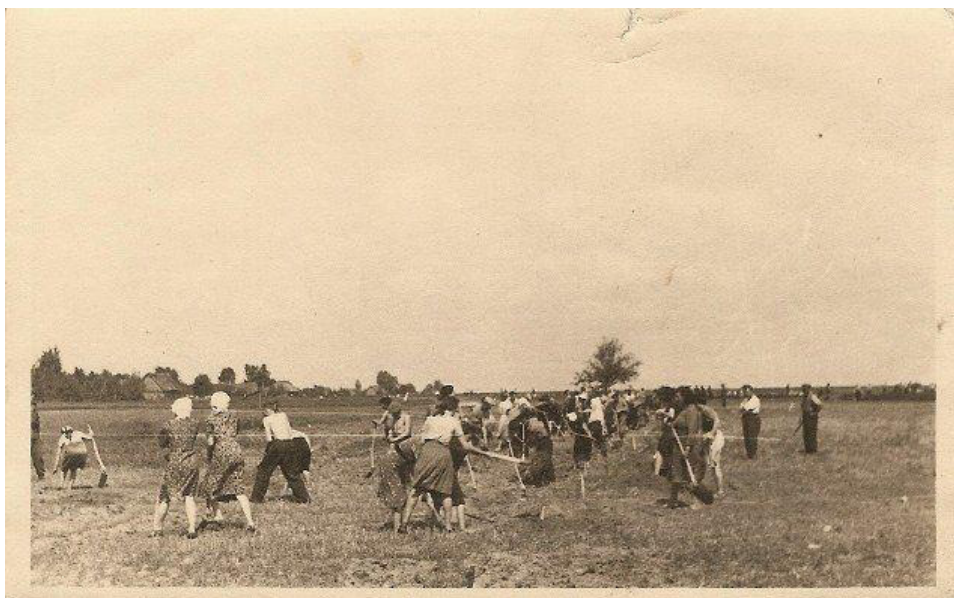
Ilustr. 1. Budowa pozycji obronnych.
